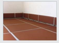
Konventioneller Zementestrich verformt sich bei der Trocknung an den Rändern nach oben ("Schüsseln"). Geht diese Verformung wieder zurück, senkt sich der Estrich am Rand samt Oberbelag wieder ab. Dabei reißt die Randfuge ab und bildet unschöne und unhygienische "Schmutzfugen". Fließestrich "schüsselt" nicht – die Randfugen bleiben intakt.
